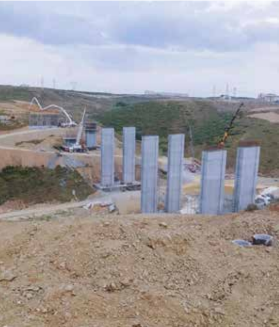
Başakşehir İlçesi, Kayaşehir Bölgesi Tem Otoyolu-Eski Ediren Asfaltı Arası Yol, Kavşak Uygulama projesi. Viyadük yükseklik max h;35 m'dir.
