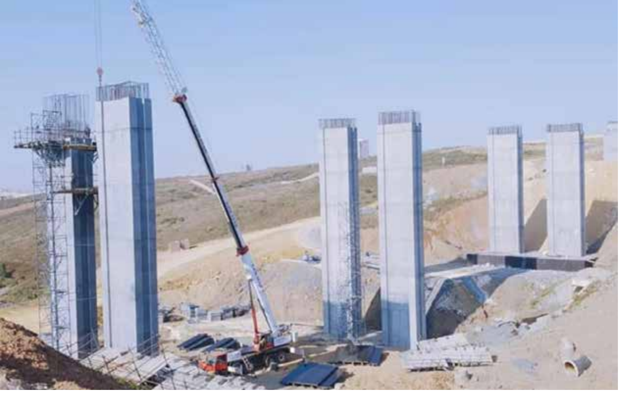
Başakşehir İlçesi, Kayaşehir Bölgesi Tem Otoyolu-Eski Ediren Asfaltı Arası Yol, Kavşak Uygulama projesi. Viyadük yükseklik max h;35 m'dir.
